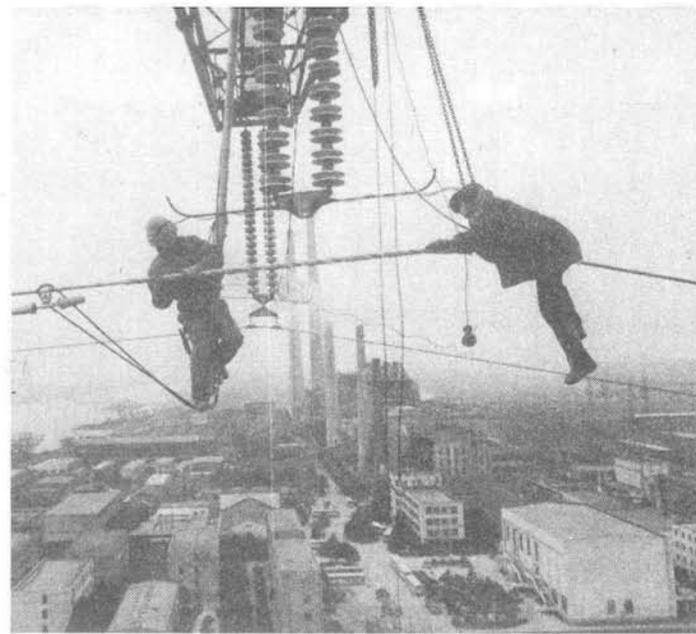
上海の浦西から浦東への22万ボルト送電線の取り換え。これによって送電が倍増した。
