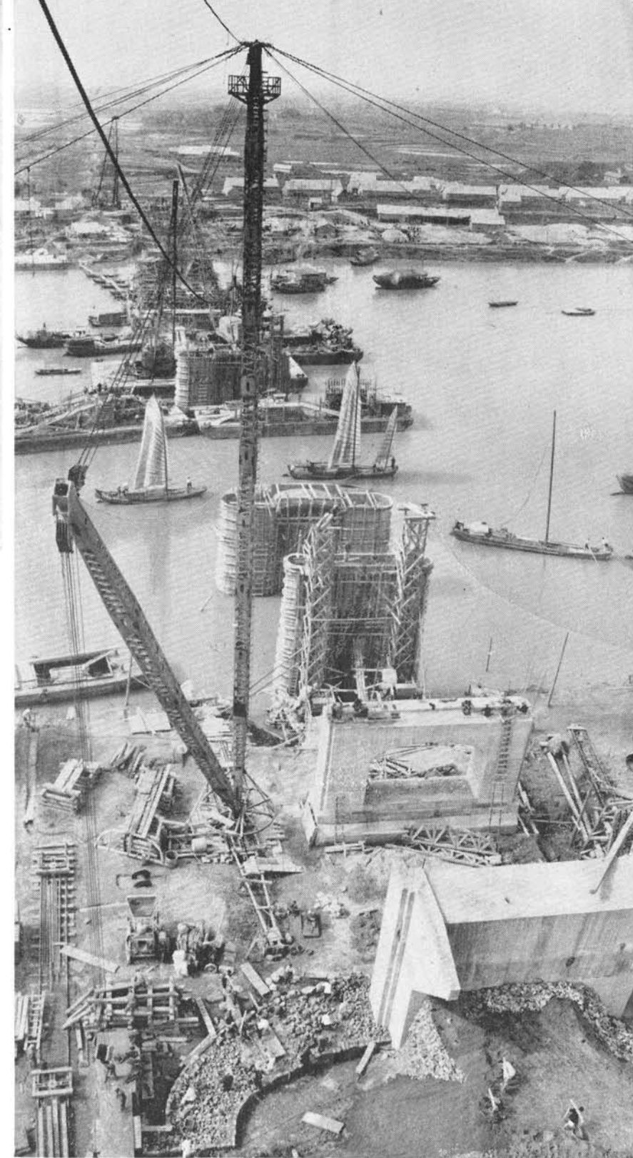
漢水鉄橋工事現場全景
